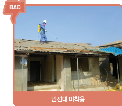
안전대 부착설비 설치 및 안전대 착용
